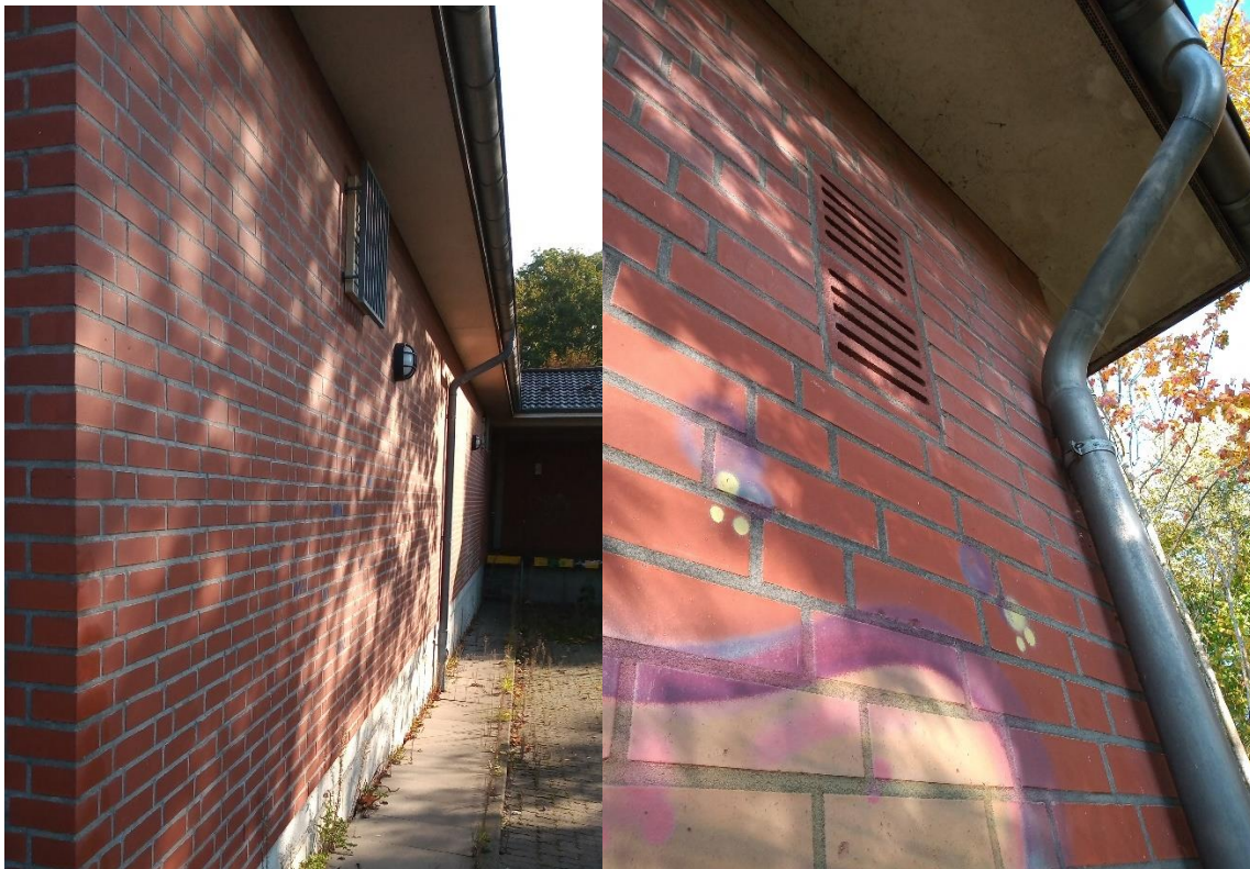
Abbildung 7: Fassade des Gebäudes und Dachüberstand
